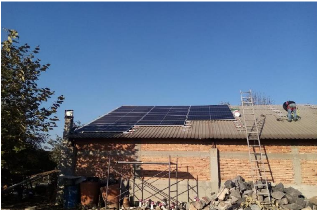
Figura 6. Colocación de paneles
